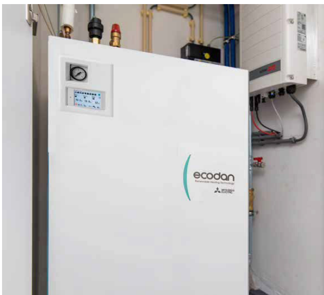
Warmtepompinstallatie.
