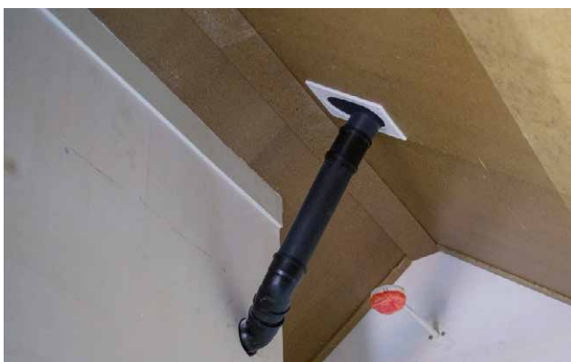
Een dakdoorvoer-inpandig.
